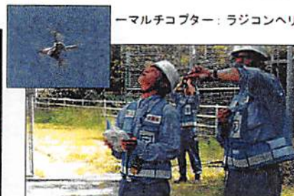
マルチコプターによる被災状況調査
