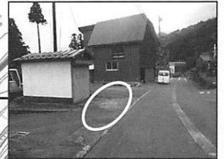
⑤ 堀切消防器具庫前
