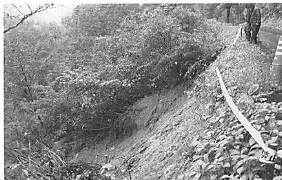
苗場線災害復旧現場
