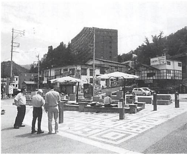
監査対象工事の現場視察の様子
