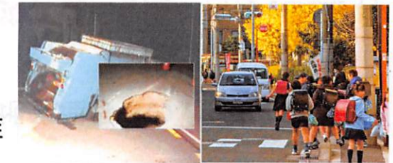
下水道の老朽化 による道路陥没
