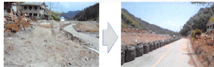
災害時の道路啓開
