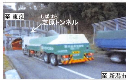
狭小トンネル入口で停車する大型車
