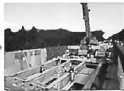
古い床版撤去状況
