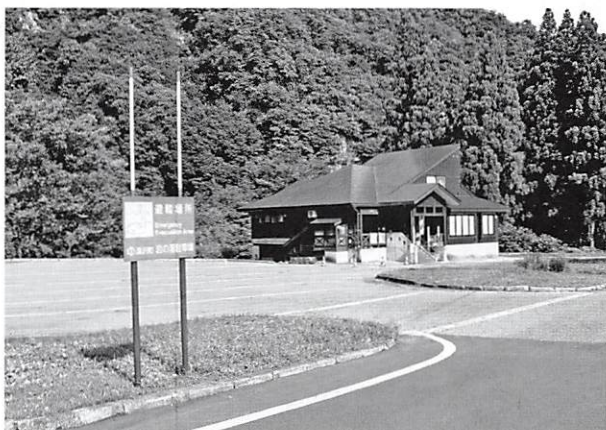
避難場所岩の湯駐車場
