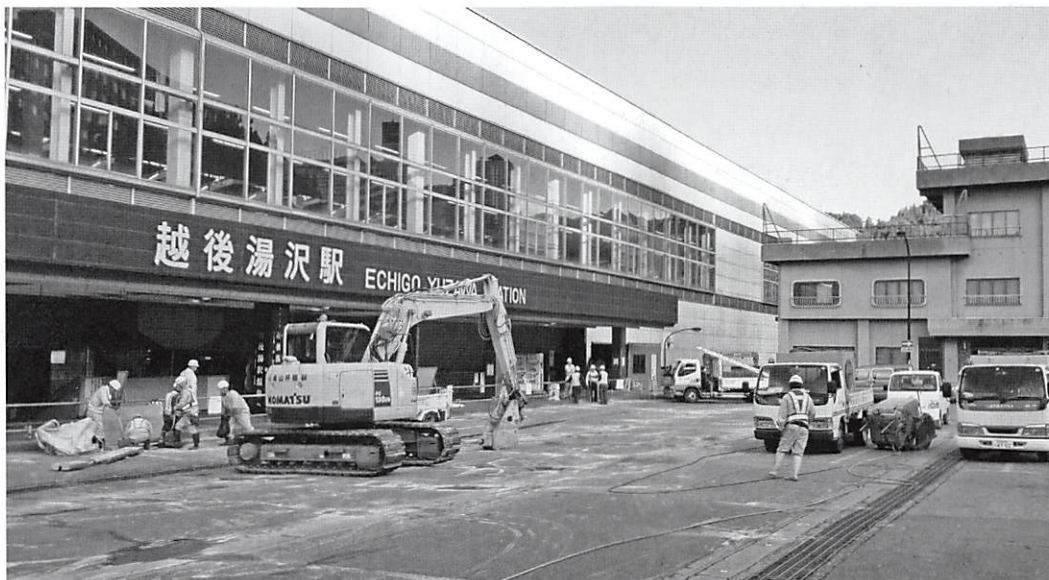
工事中の越後湯沢駅西口広場 (9月3日)
