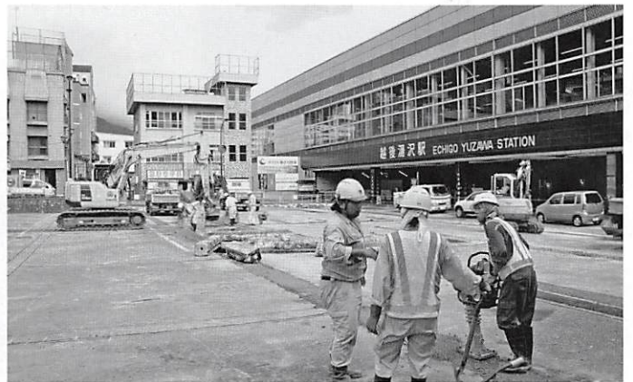
西口駅前広場改修工事(9月5日)
