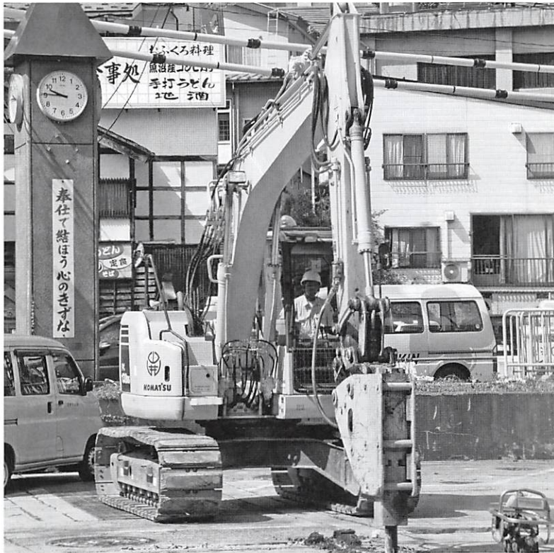
作業中の西口ロータリー
