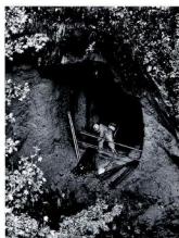
排水トンネル
