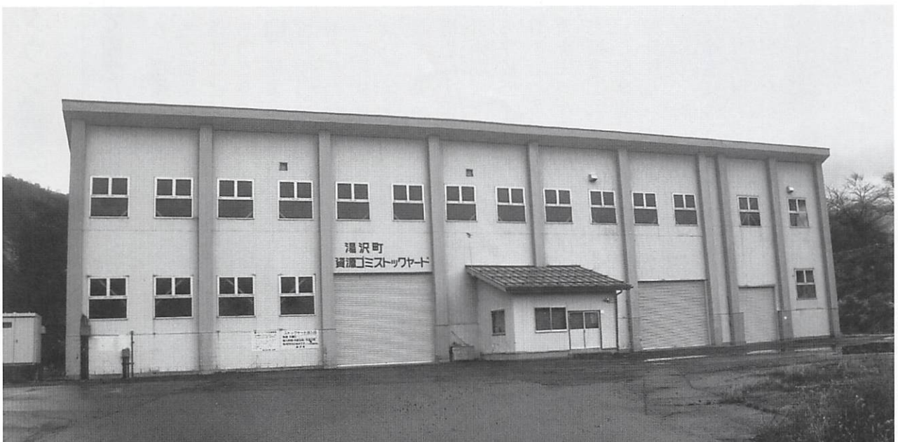
町民が利用するストックヤードは今後も大切な施設
