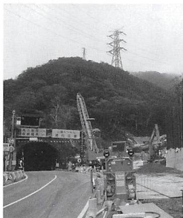
工事中の三国トンネル
