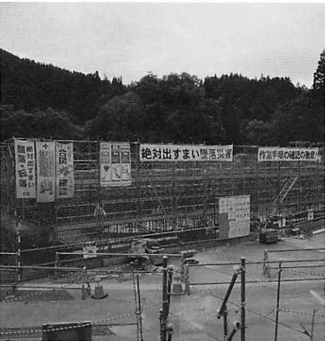
工事中の三俣浄化センター
