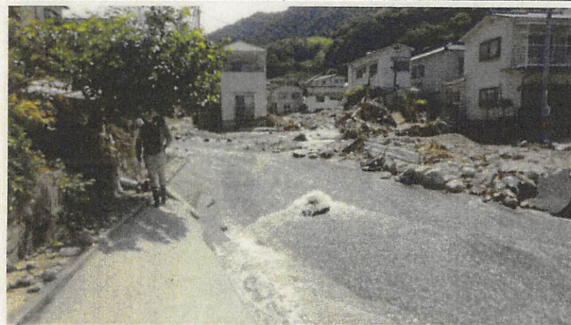
大屋大川(広島県呉市) 河道が埋塞し、土砂が氾濫することで新たな区域に災害リスクが拡大
