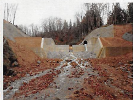
整備中の市ノ沢第2号砂防堰堤
