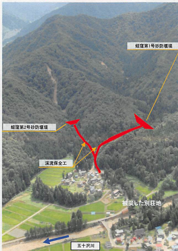
三国川中流域土砂災害対策 (蛭窪砂防堰堤群)
