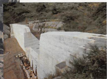
整備中の南平アシ沢砂防堰堤
