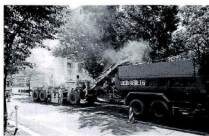
工期が変更された舗装改修工事
