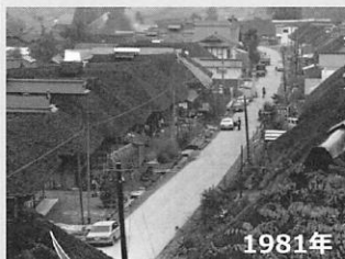
大内宿の茅葺き民家郡再生(福島県)
