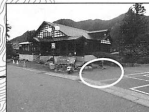
② 駒子の湯駐車場
