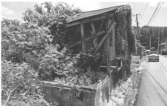
町内に点在する放置廃屋
