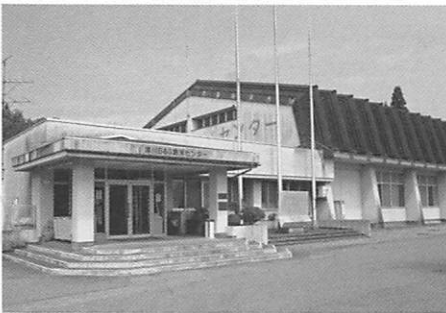
改修予定の津川B & G体育館
