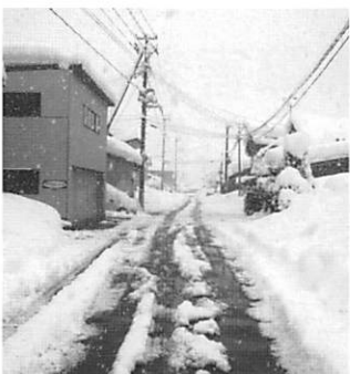
大雪でまにあわない消雪パイプ
