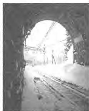
上越線 下り 清水トンネル出口
