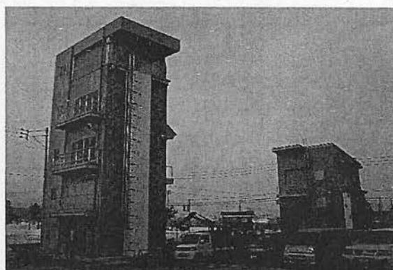
消防訓練主塔・副塔
