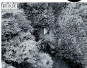
大源太川防砂堰堤工事 仮排水トンネル
