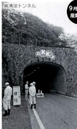
奥清津トンネル
