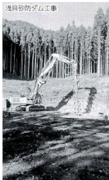
浅貝砂防ダム工事
