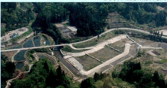
河川の増水に備え土砂を受け止める遊砂地(魚沼市竜光地区)
