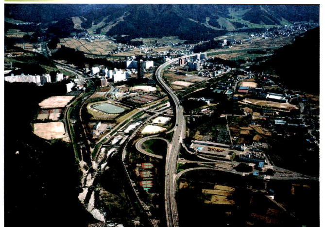
魚野川・大源太川流路工が整備された現在の同地区
