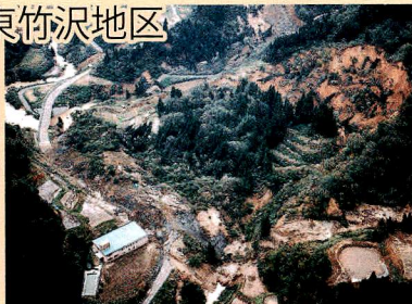
地すべり及び河道閉塞発生状況 (H16.10.24撮影)
