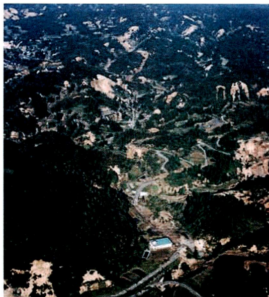
芋川流域における崩壊状況
