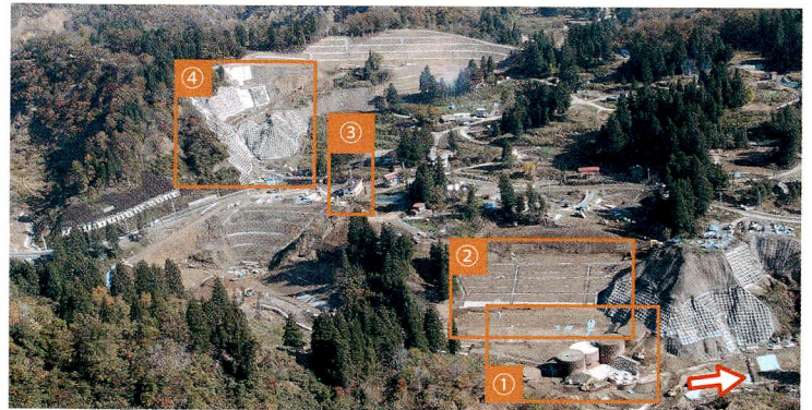
地すべり対策工事(梶金地区)
