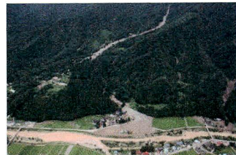
小川地区土石流災害(南魚沼市・三国川)
