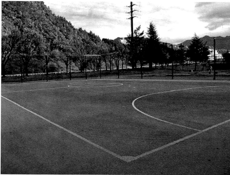
平成28年度より共用開始される 中央公園フットサルコート
