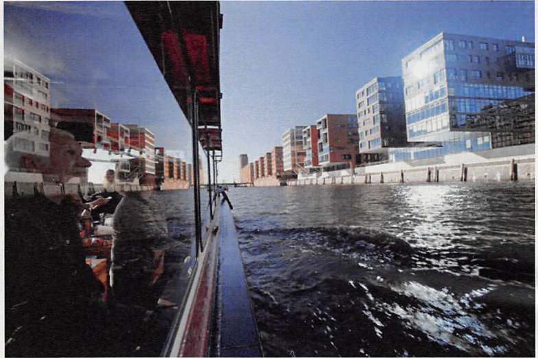
工事現場を見学するクルーズ
